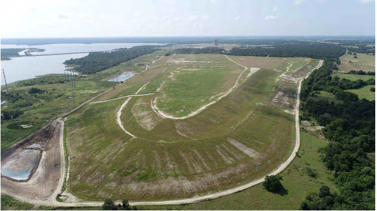
Site A Landfill (5/24/2023)
